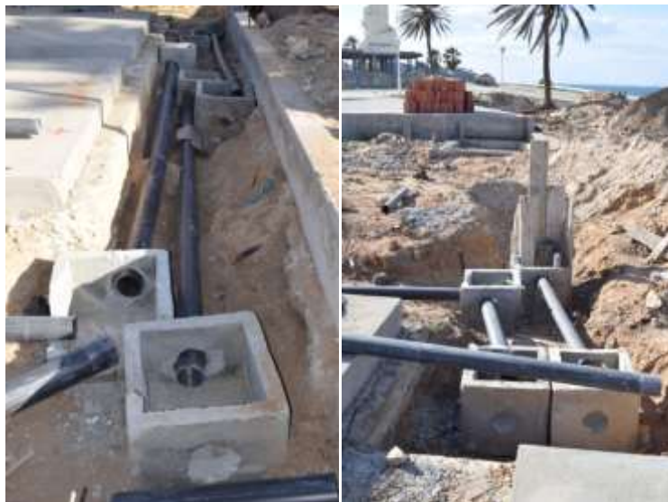
FIGURE 6: Photos des travaux de VRD
