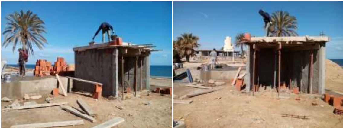
FIGURE 9: Photos du local technique (en cours de construction)
