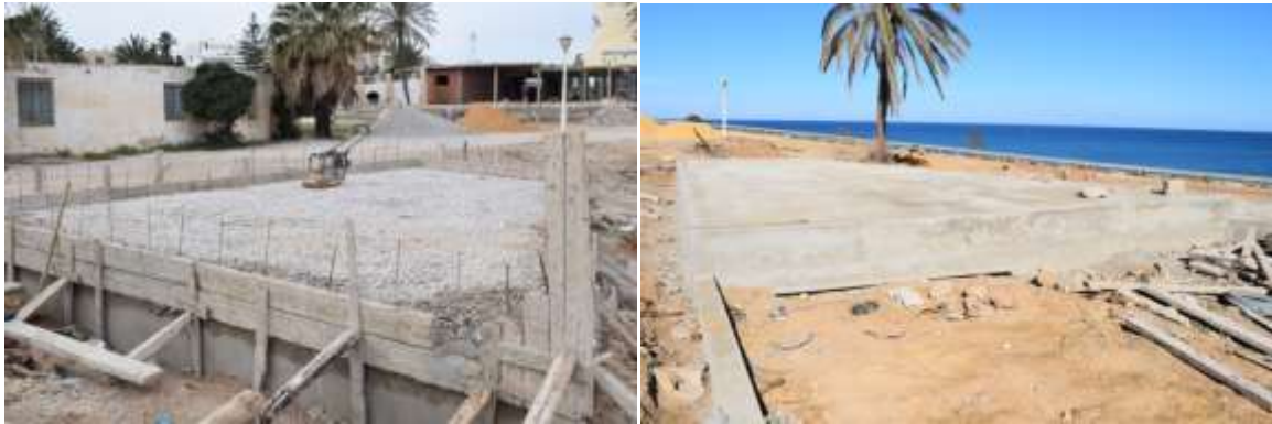
FIGURE 8: Photos construction de la plateforme des panneaux photovoltaïques
