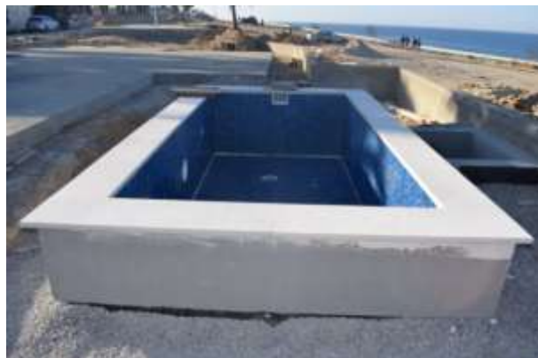
FIGURE 16: PHOTO DE L'ETAT FINALE DE LA PISCINE
